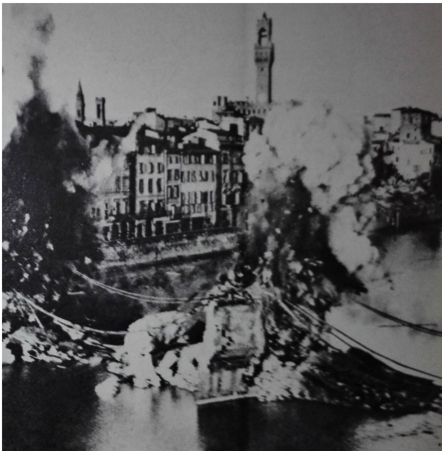
Il crollo del Ponte Santa Trinita minato dai tedeschi.
