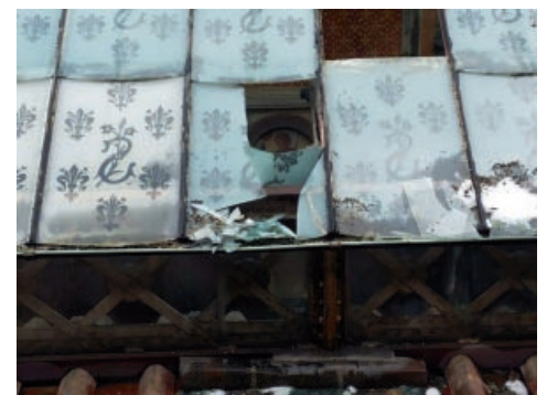
Alcuni pannelli della vetrata del Chiostrino dei Voti dei danneggiati dal vento e dalla grandine del 19 settembre.
